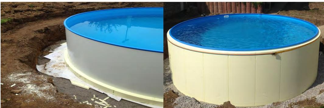
Für die Beckenhöhen 135 cm und 150 cm werden Rundschalungselemente mit 15 cm Höhe mitgeliefert. Diese sollten als erste Lage auf der conZero Bodenplatte verlegt werden. Die Schalungselemente mit 120 cm Höhe werden anschließend aufgesetzt.
