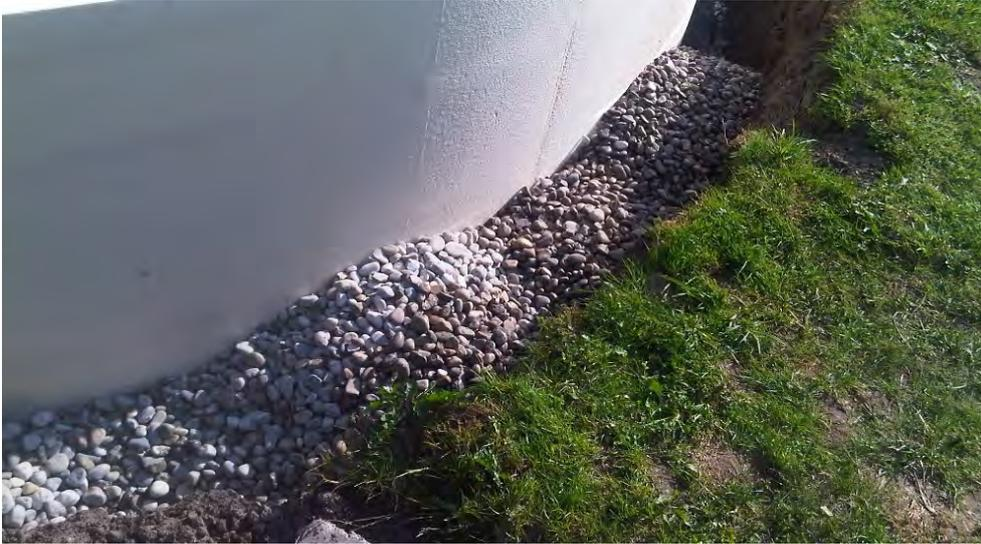
Drainage Rollkies der Größe 8-16 mm in den verbleibenden Zwischenraum einbringen.
