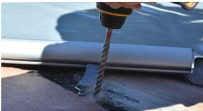
Legen Sie die Beschläge gerade aus, bohren Sie Löcher für die Senkstifte.
