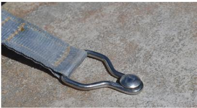
Die Beschläge an den Senkstiften befestigen und die Abdeckung spannen.
