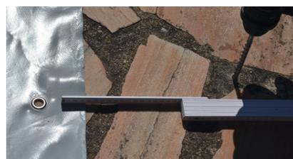
Montieren Sie die Senkstifte für die Windverankerung. Ca. 20 cm von den Ösen der Abdeckung sollten Sie die Senkstifte dafür einbringen.
