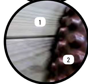
1- Houten frame 2- Rol HDPE-noppenfolie ter bescherming en voor de drainage
